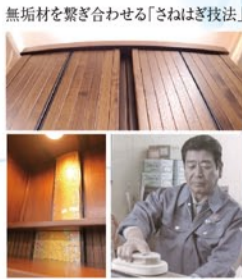
無垢材を繋ぎ合わせる「さねはぎ技法」 「みかげ塗」戎谷有輔氏 阿波の名工
